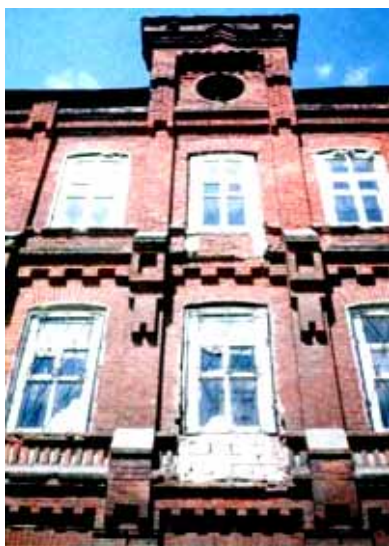
Фрагмент одного из 9 зданий фабрики Кондрашевых (в XX веке - «Техноткань»)
